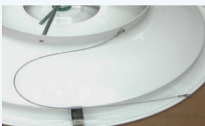
**4.** Fijar la cabeza del cable de acero de seguridad (D) a través del tornillo y la tuerca (M5) que se entrega con el Kit KD. Fijar el extremo del cable de seguridad a la estructura del falso techo.
